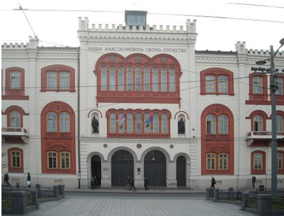
Слика 6. Зграда Београдског универзитета, (фото: Н. Јанц, 2017).
